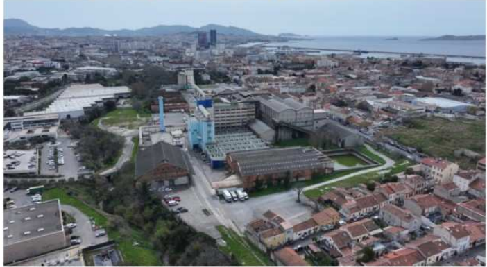
Figure 18 : Site avant démolition (Source : permis de construire)
